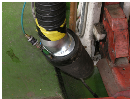
Fot. 2. System indywidualnych wyciągów połączony z analizatorami spalin
