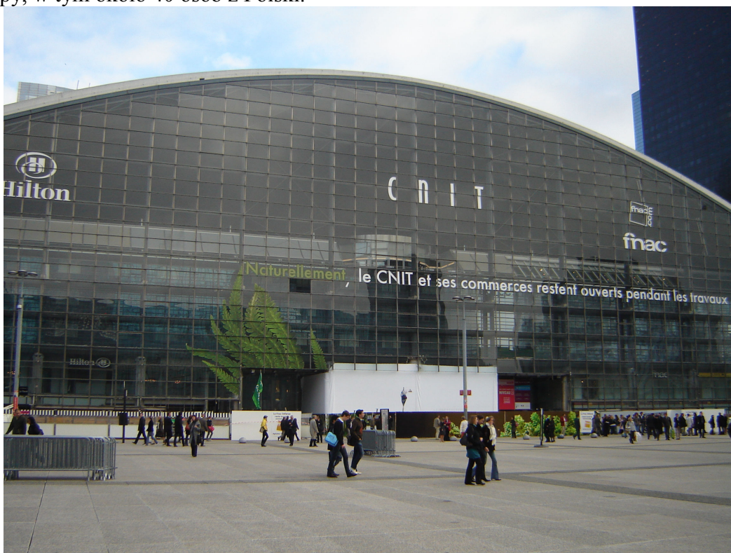
Fot. 1. Miejsce Konferencji - Place La Grande Arche
