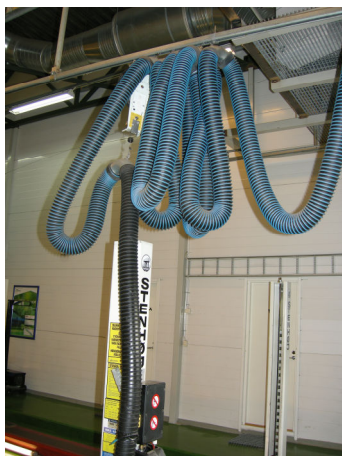
Fot. 2. System indywidualnych wyciągów połączony z analizatorami spalin
