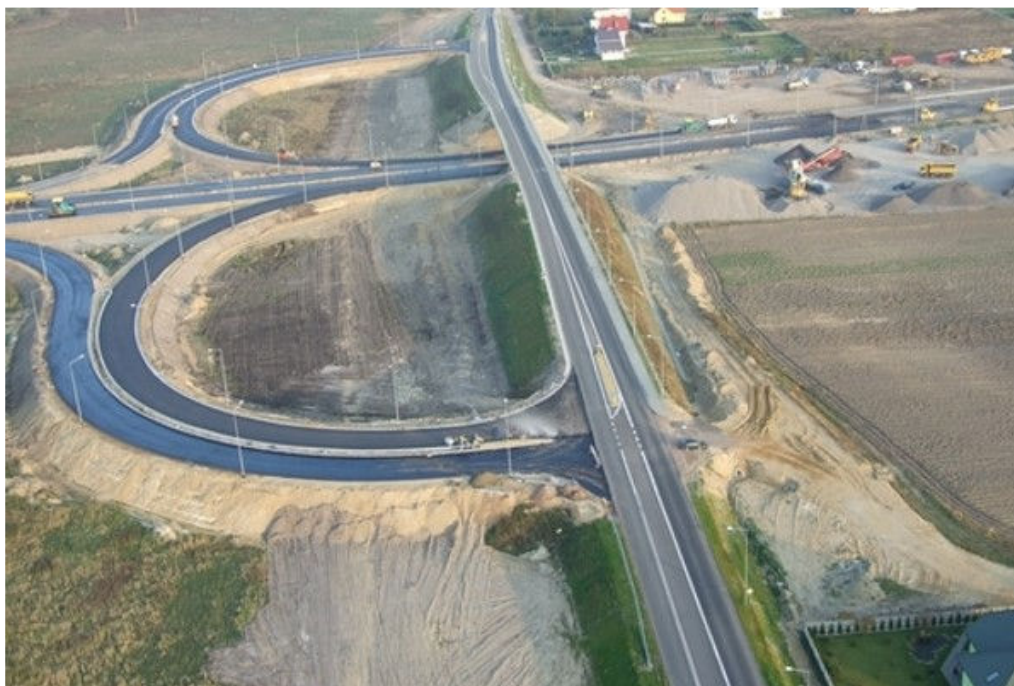
Fot. 1. Droga krajowa nr 19. Końcowa faza budowy obwodnicy Międzyrzecza Podlaskiego.
